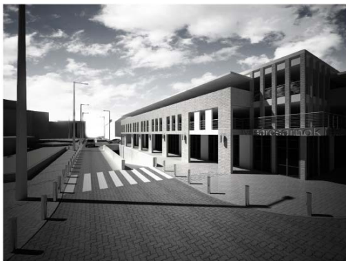
Centrum felőli homlokzat
