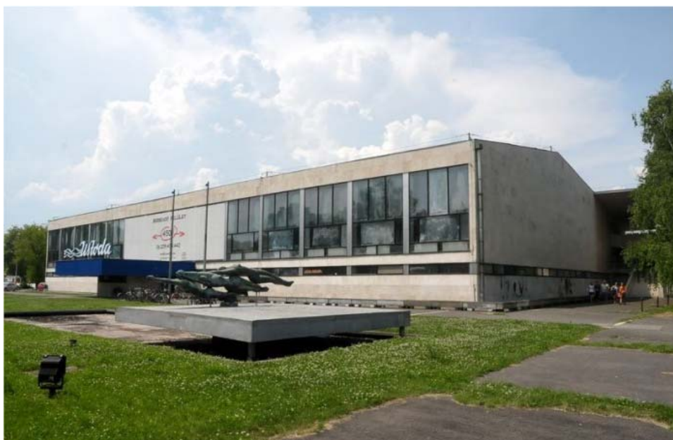
56. ábra: A hasznosításra váró volt fedett uszoda épülete
