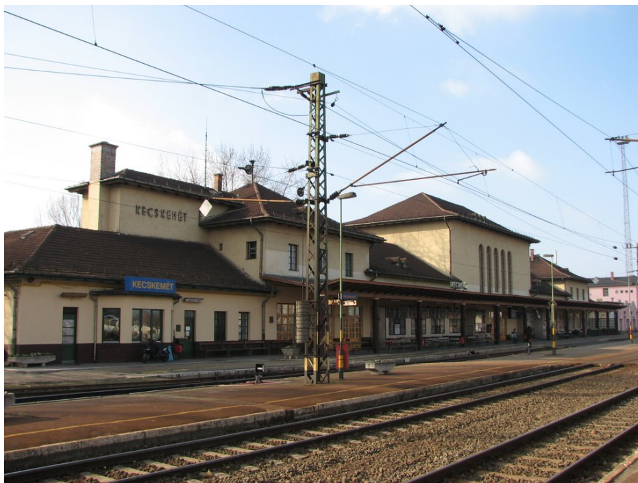
32. ábra: A Kecskeméti vasútállomás épülete
